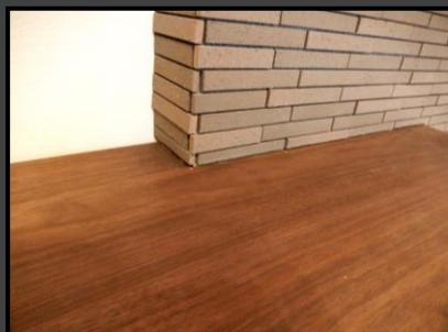
▲壁面の凹凸に合わせて本体に加工を施し、綺麗に取り付けされた様子。
