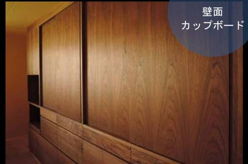
天井までの壁面カップボードの完成です。ウォールナットの無垢材と突板を使用した前面が見事！大容量の収納力でキッチン周りもすっきり。引出し部分に無垢材を使用し、格子状に加工しました。お客様のこだわりポイントです。
